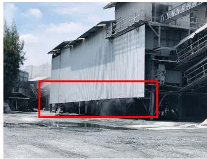
รูปที่ 2-8: ระบบสเปรย์น้ำของโรงโม่
