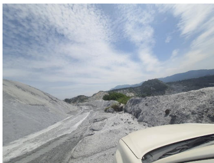
รูปที่ 2-35: คันทำนบดินและคูระบายน้ำบริเวณขอบบ่อเหมืองด้านที่ติดกับโรงโม่หิน
